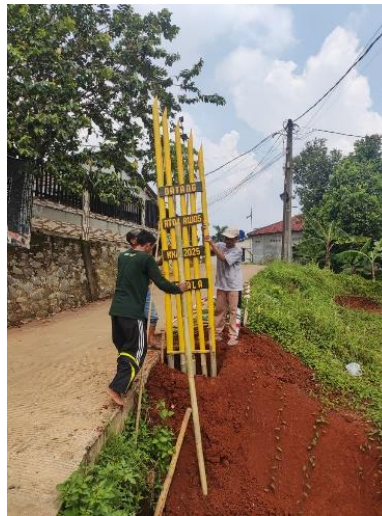
Gambar 4. Mahasiswa KKN Sukmajaya Membuat Pondasi Bagian Bawah Gapura
